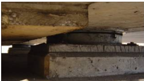
Figura 6: Apoios da ponte.
