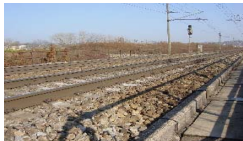
Figura 7: Vista da via férrea sobre a ponte.
