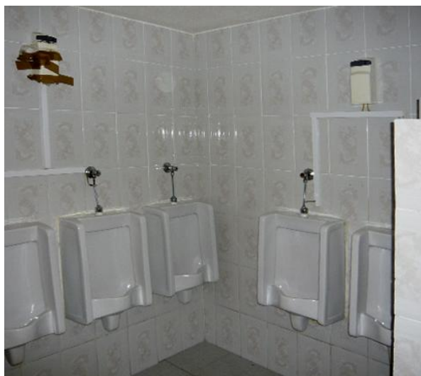
Fotografia 5- wc antes- interior
