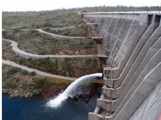
Figura 10: Barragem do rio Águeda
