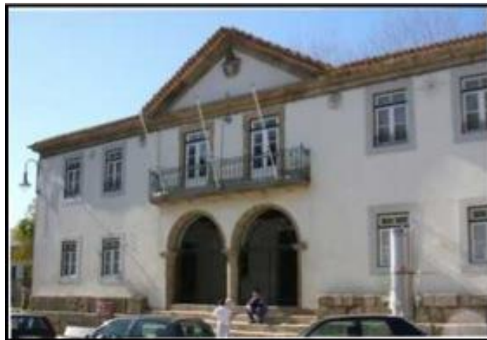
Figura 2 - Imagem do edifício onde está sediado o Conservatório de Música de Seia 2 .
