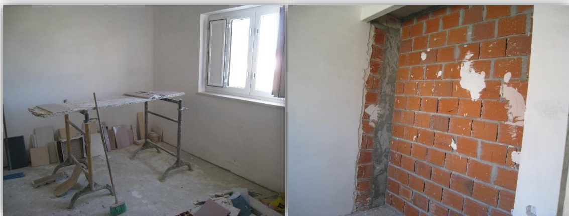
Figura 96 - Foto-documentação - Execução inicial do projeto, quarto 2.
