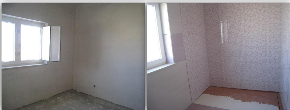
Figura 97 - Foto-documentação - Execução inicial do projeto, quarto 1 e wc1.
