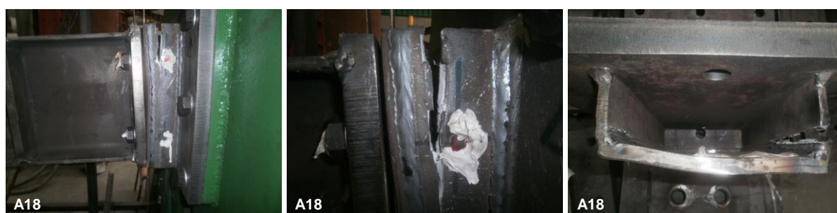
Figura 13. Rotura do protótipo A-18 nas placas de banzo.
