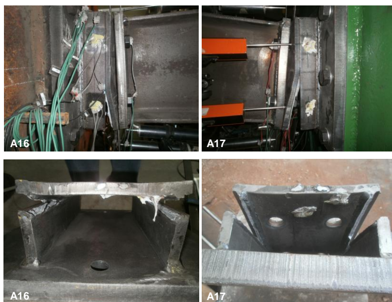
Figura 12b. Rotura dos cordões de soldadura nos protótipos A-16 e A-17.
