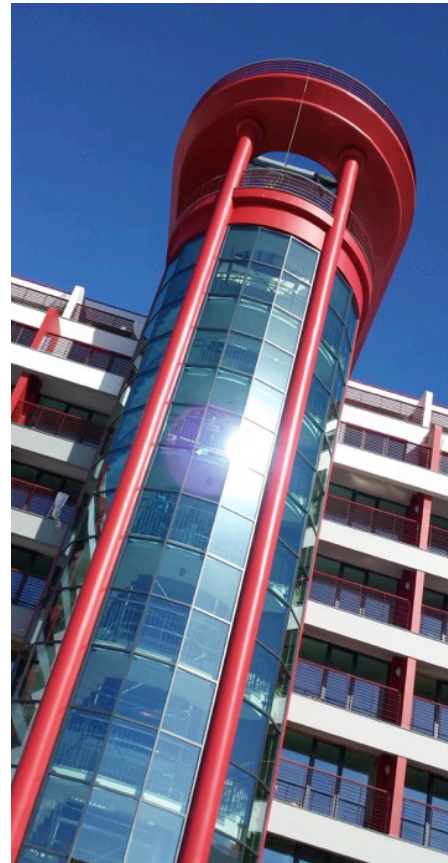
Imagem 137. Registo fotográfico da execução de obra
