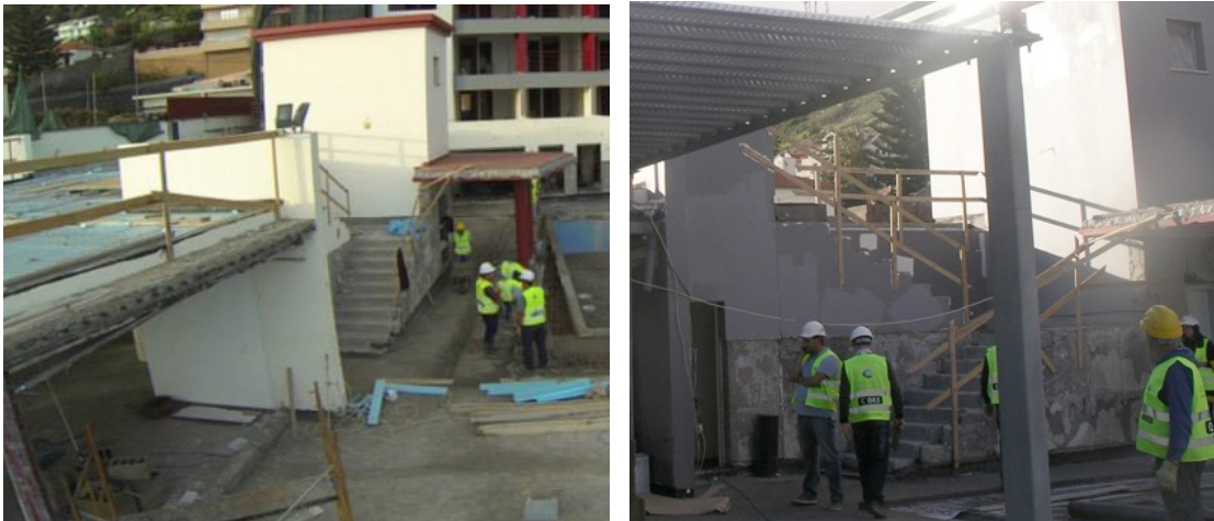
Imagem 135. Fotografias em obra, da área onde seria aplicado o pavimento Rosa Gres
