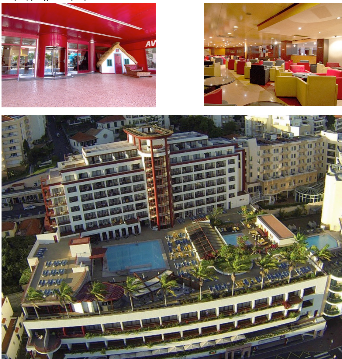
Imagem96. Fotografias dos interiores e exteriores do HFVM, antes da intervenção por parte do Espaço FA e da Construart
