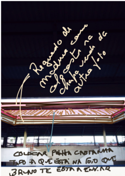
Imagem 47. Fotografia de obra (pátio), com anotações para aplicação de materiais através de fotomontagem, fotografia enviada pela Arq. Fátima aquando da visita à obra no Brasil.
