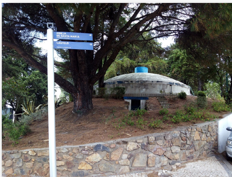
Figura 16 - Reservatório de São Gens, arranjos exteriores em 2008 pelo POLIS (reservatório enterrado).
