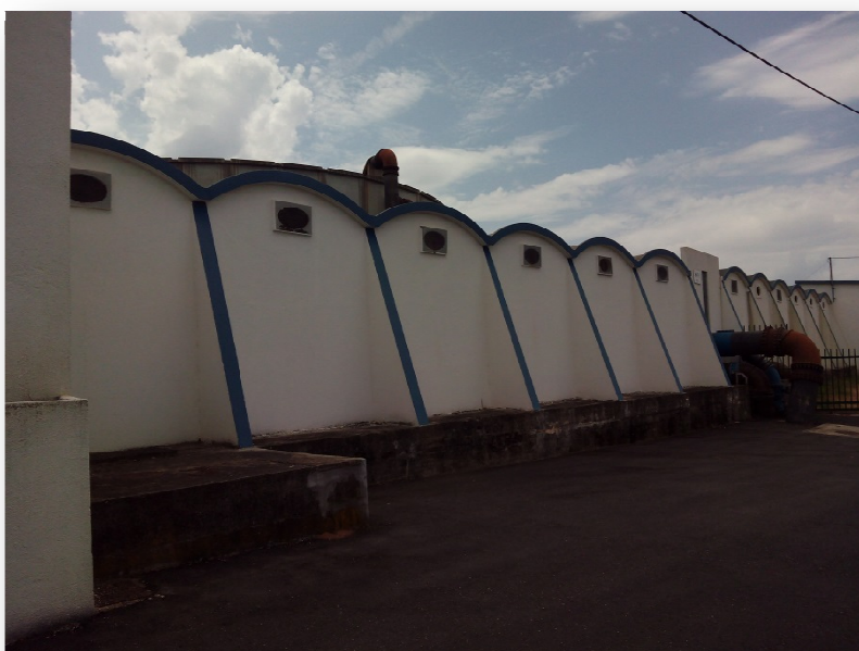
Figura 14 - Estação elevatória do Lirião.
