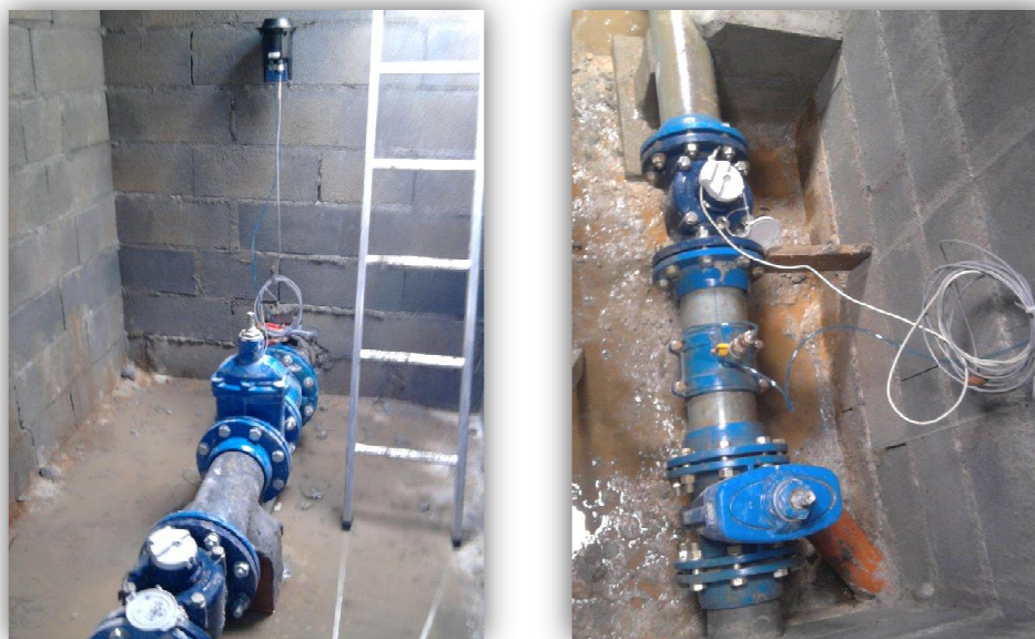
Figura 41 - Espaço de medição e controlo da ZIS (troço t163) e ZIN (troço t141).
