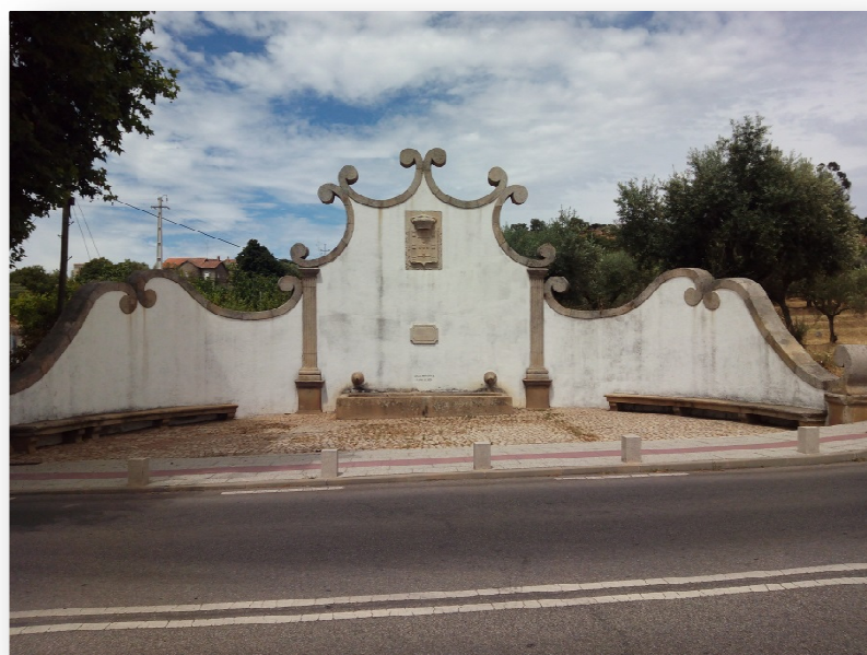
Figura 7 - Chafariz do Cansado construído em 1848.
