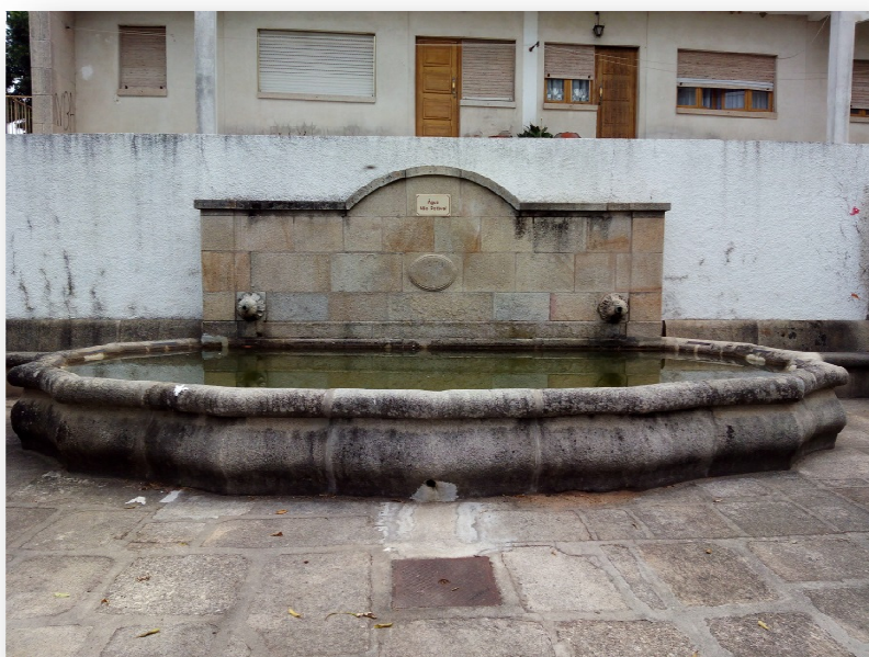
Figura 9 - Chafariz da Granja de baixo construído em 1875.
