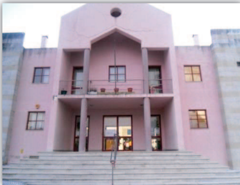
Figura 6 - Fachada principal da Escola Básica da Quinta da Granja
