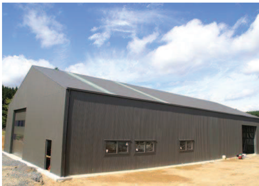
Figura 33- Edifício da unidade apícola
