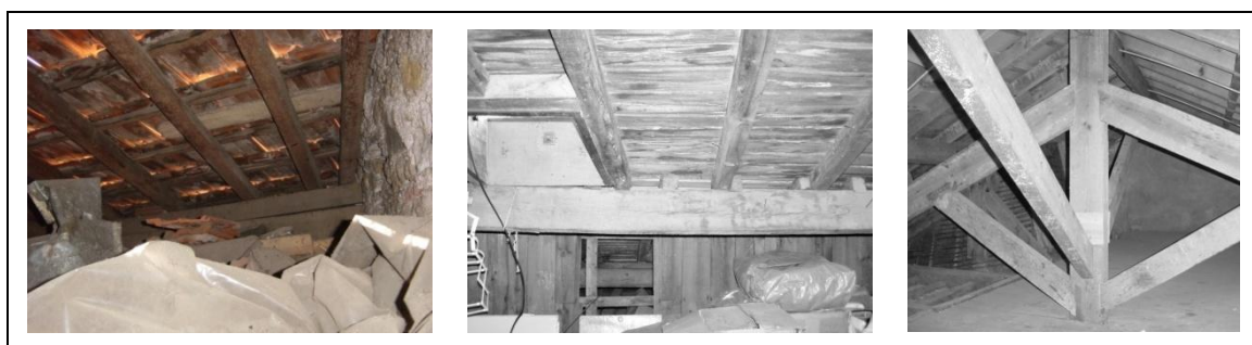
Figura 59. Alguns exemplos de estruturas de madeira
