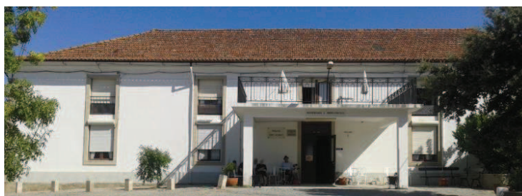
Figura 10 – Imagem exterior do Pavilhão B.
