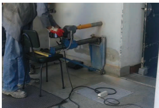
Figura 17 – Execução do furo de corte pela carotadora.
