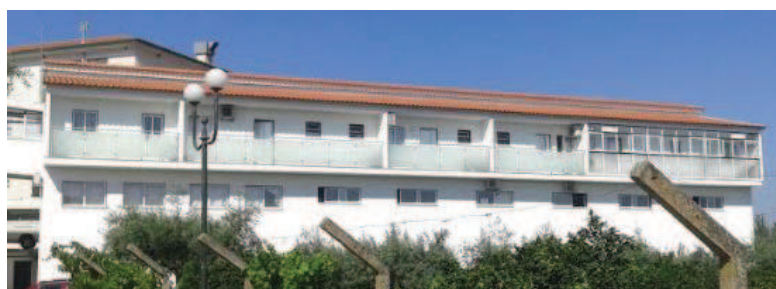
Figura 20 – Imagem do Pavilhão I.
