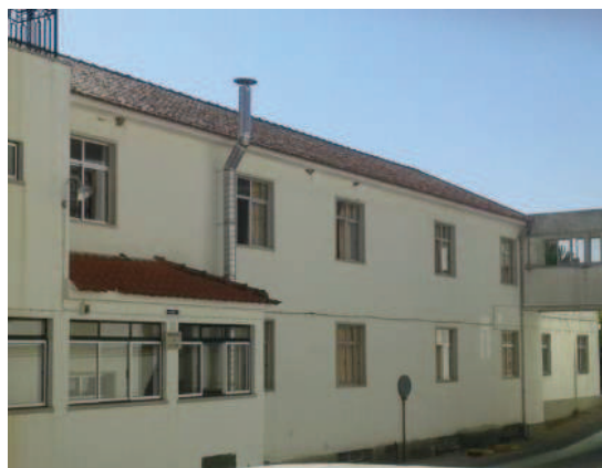
Figura 19 – Imagem exterior do Pavilhão H.
