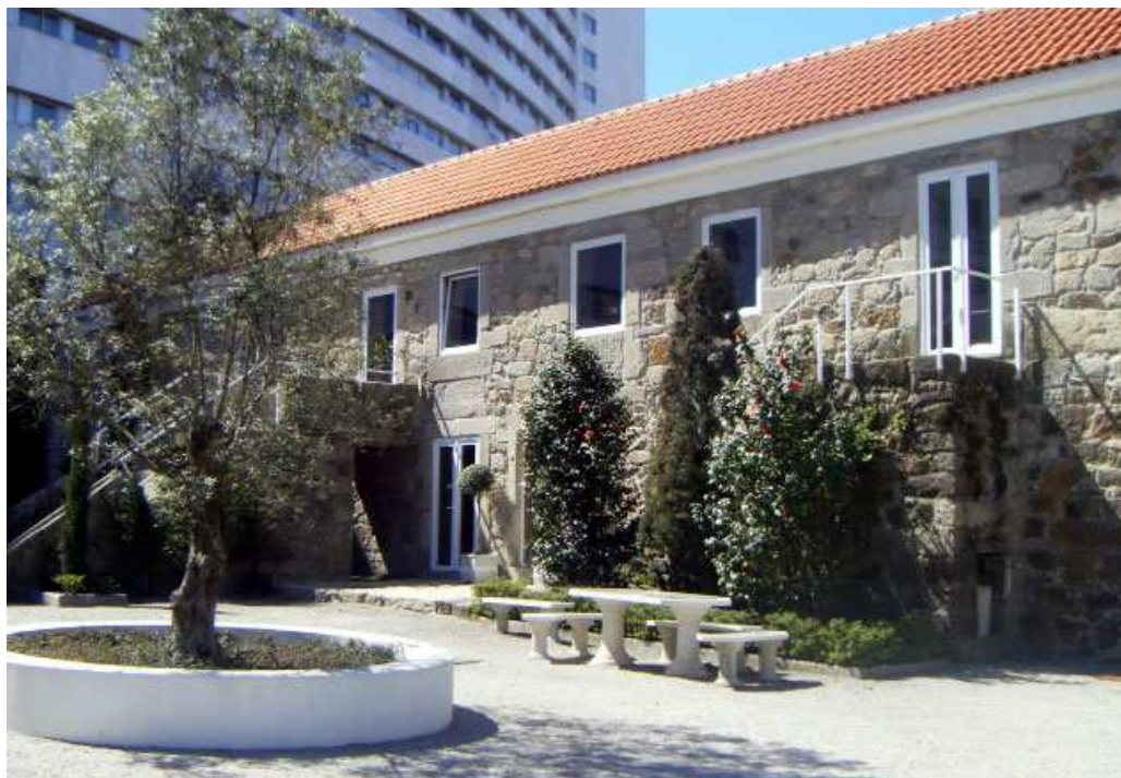
Figura 1 - Instalações da Fundação Conservatório Regional de Gaia (Fonte: Fundação Conservatório Regional de Gaia, 2014)
