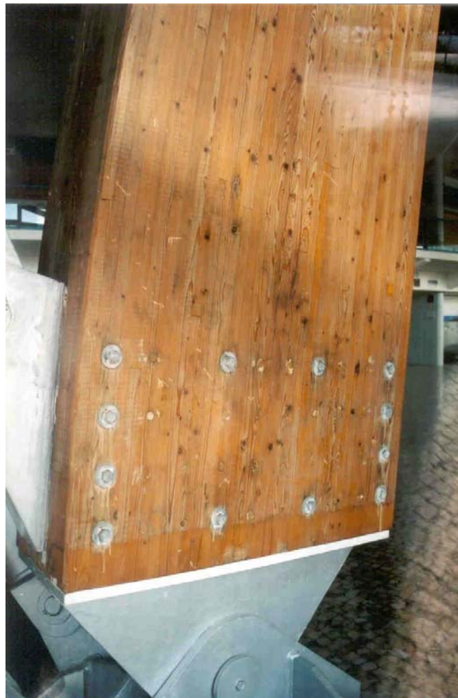
Fig. n.º 9 – Ligações de elementos estruturais metálicos à madeira, com recurso ao parafuso, anilha e porca, no Pavilhão Atlântico, em Lisboa.
