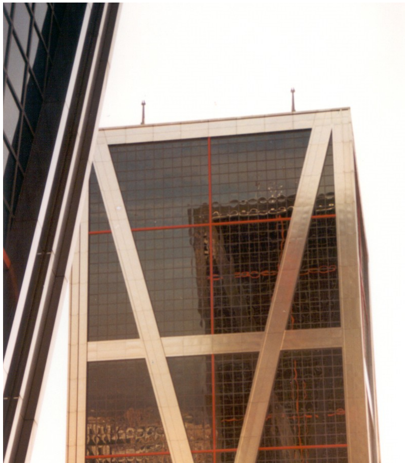
Fig. n.º 46 – As torres Kio, vista dos dois guinchos que suportam o bailéu.
