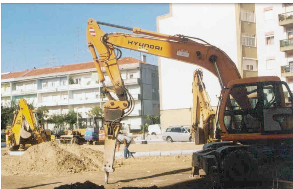
Fig. n.º 29 – Exemplo de escavadora com martelo pneumático.
