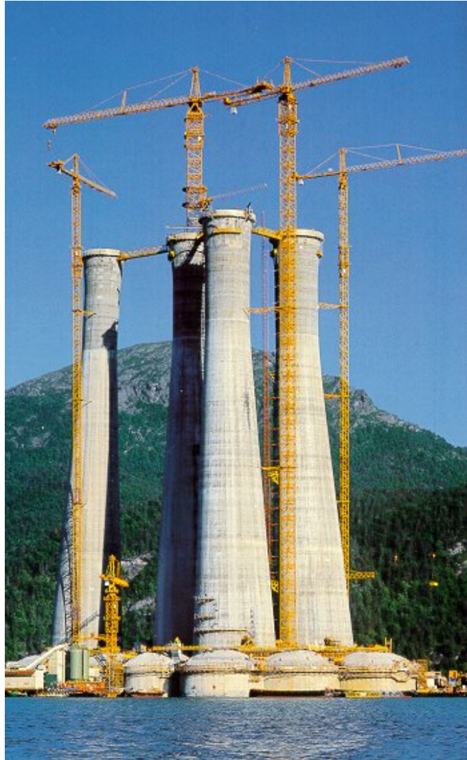
Fig. n.º 4 – A construção de um offshore . (Liebherr)
