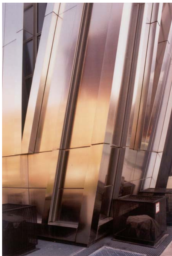
Fig. n.º 48 – As torres Kio, pormenor das fachadas com os carris.
