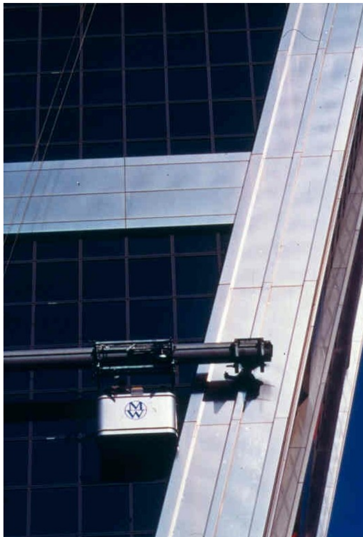
Fig. n.º 44 – As torres Kio, pormenor do funcionamento do bailéu. (FCC)
