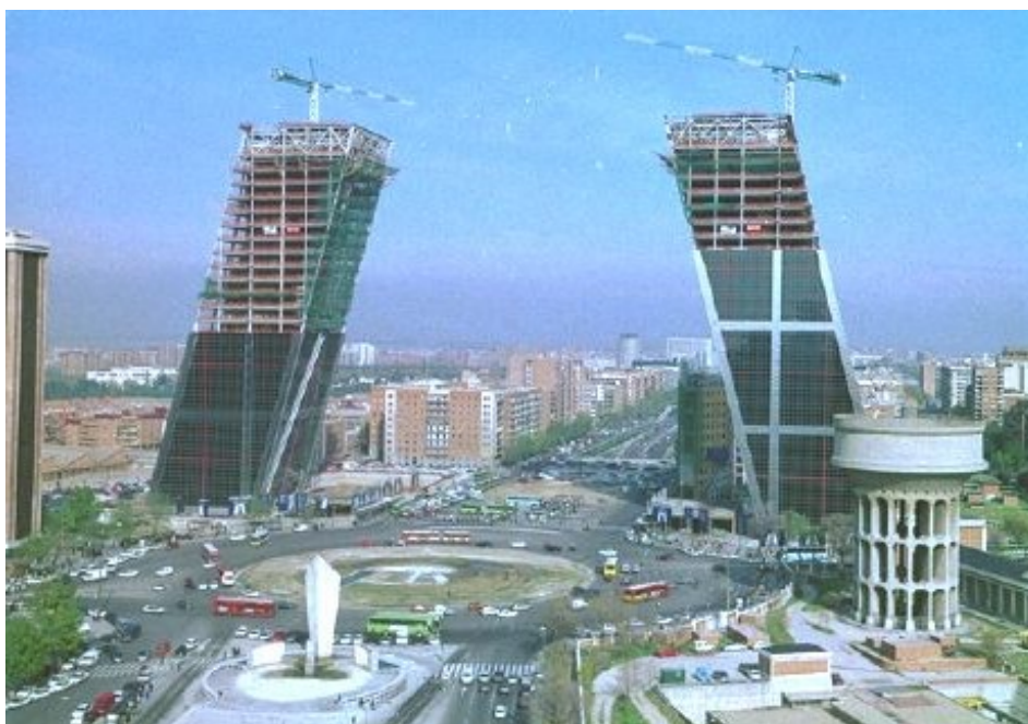
Fig. n.º 43 – As torres Kio em fase de revestimento exterior.
