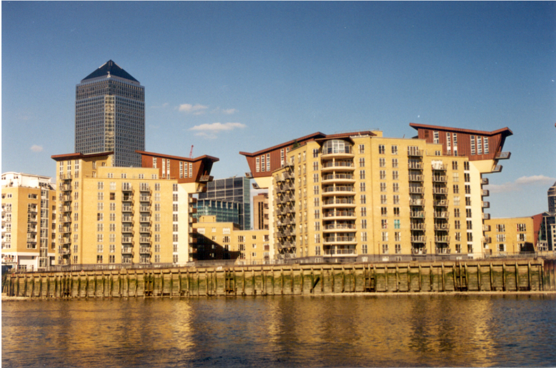
Fig. n.º 22 – Edifícios com o corpo superior saliente, em Londres.
