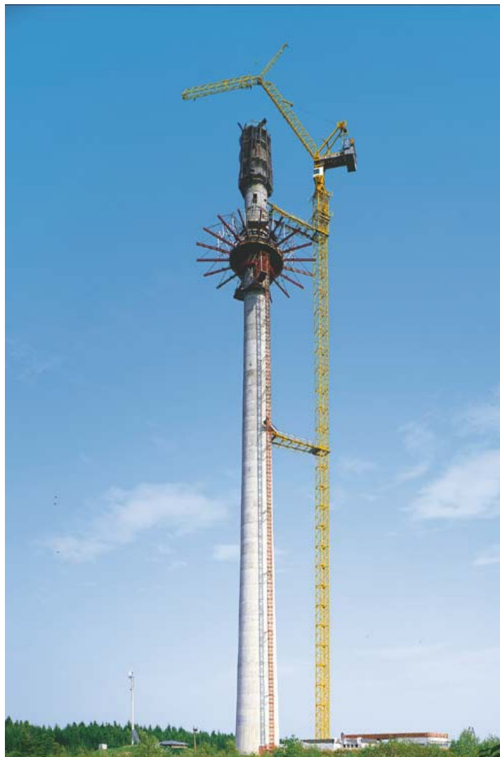
Fig. n.º 3 – A construção de uma torre de telecomunicações. (Liebherr)
