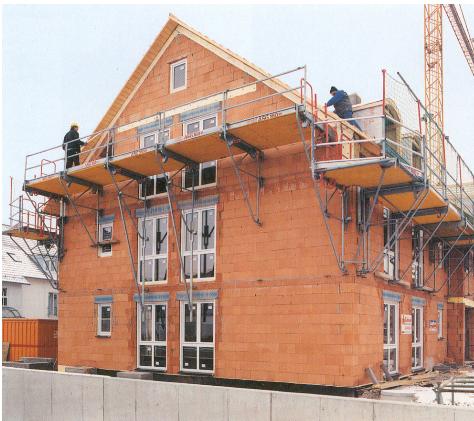
Fig. n.º 23 – A utilização de plataformas com guarda corpos. (Peri)
