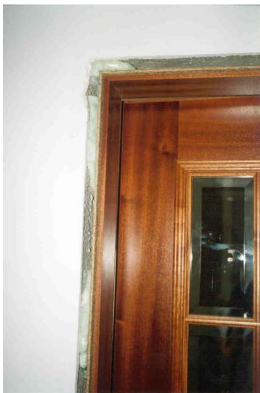
Fig. n.º 58 – A aplicação dos aros com espuma de colagem.
