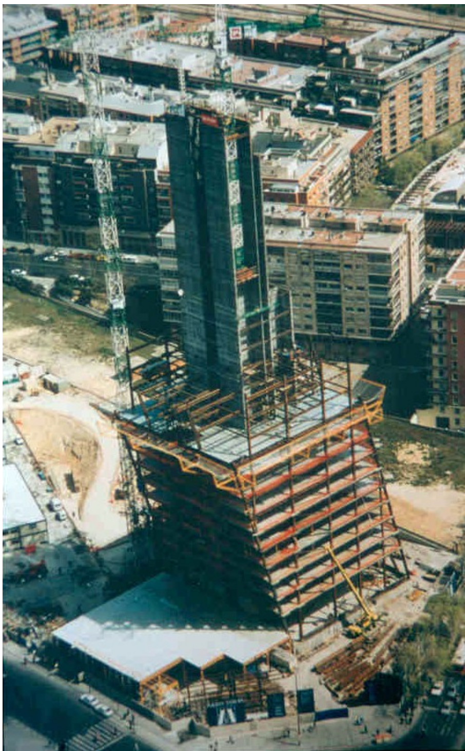
Fig. n.º 41 – As torres Kio em fase de construção (FCC)
