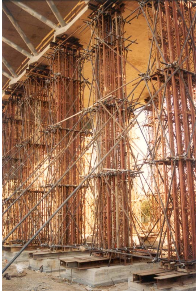
Fig. n.º 61 – O sistema cimbra ao solo na Ponte Europa, em Coimbra.
