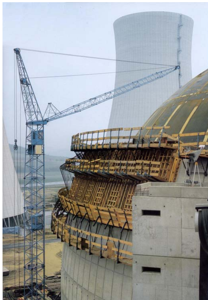
Fig. n.º 51 – Cofragem incorporando guarda corpos, (Doka).
