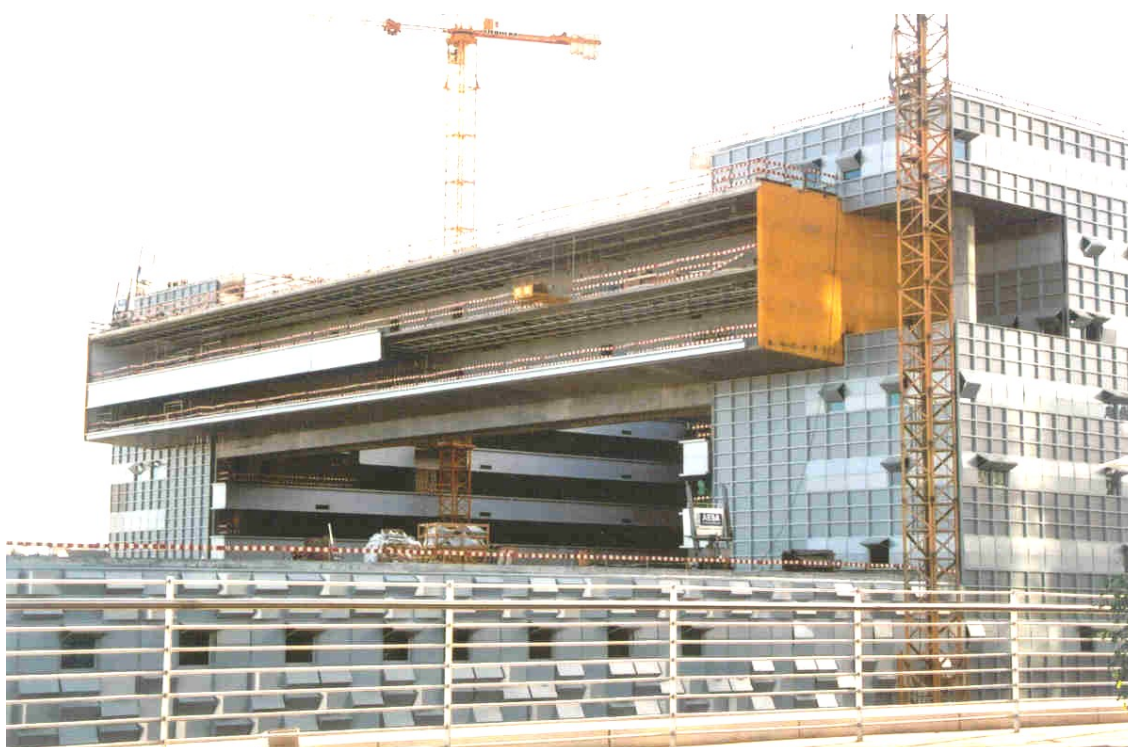
Fig. n.º 55 – O edifício Vodafone em fase de acabamentos, em Lisboa.
