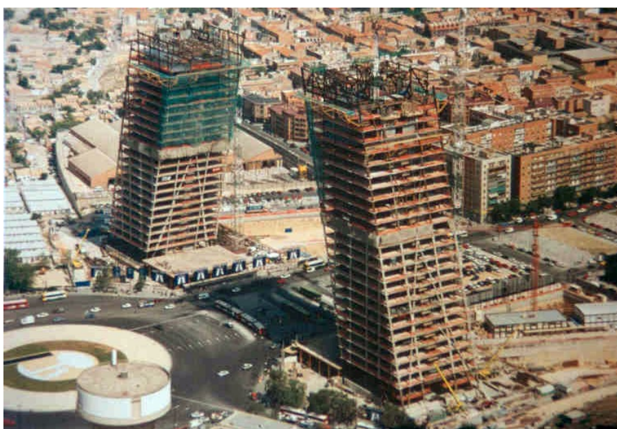
Fig. n.º 42 – As torres Kio em fase de conclusão da estrutura (FCC)
