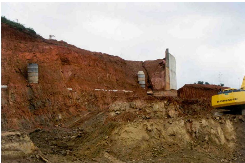
Fig. n.º 35 – Obras de urbanização em operação de loteamento urbano.
