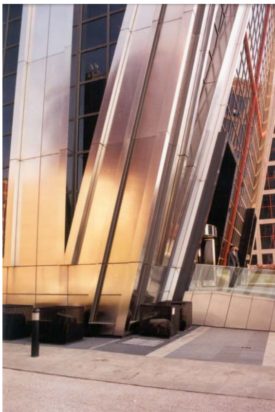
Fig. n.º 47 – Nas torres Kio os carris integram-se na arquitectura do edifício.
