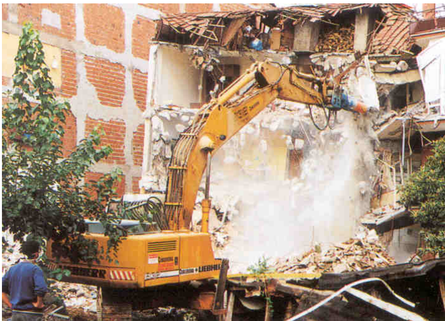
Fig. n.º 8 – A demolição de um edifício recorrendo a equipamentos pesados. (Krupp)
