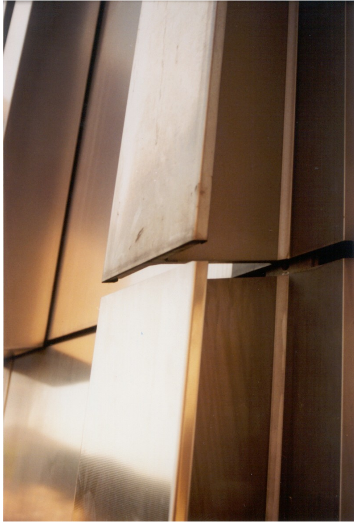
Fig. n.º 49 – As torres Kio, pormenor do carril (1).
