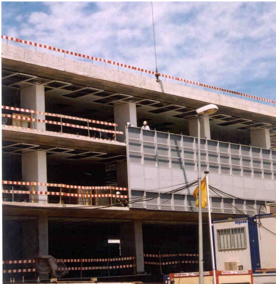
Fig. n.º 7 – A fachada pré-fabricada do edifício Vodafone, em Lisboa.
