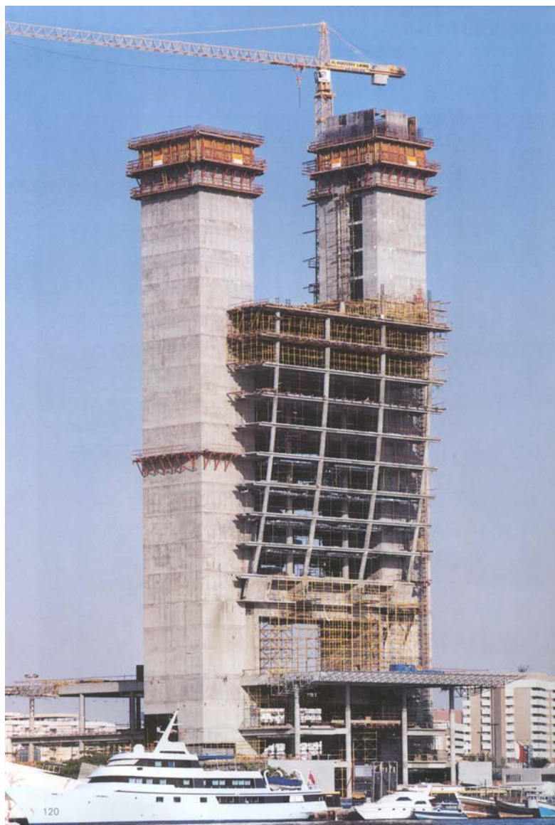
Fig. n.º 1 – Banco Nacional de Dubai em fase de construção, nos Emiratos Árabes Unidos. (Peri)
