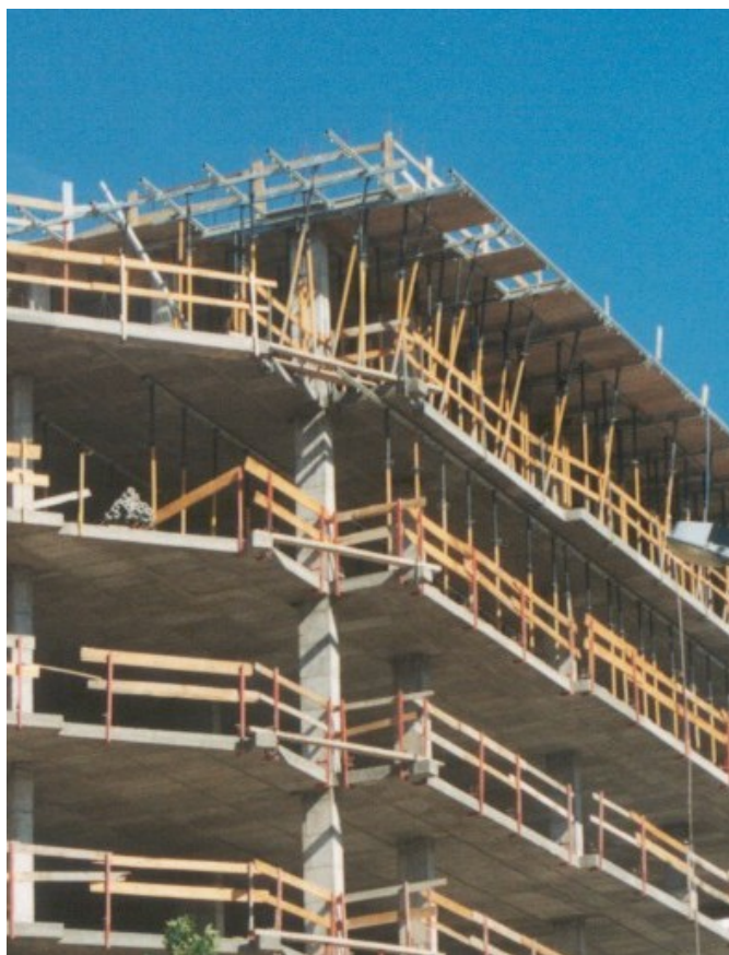
Fig. n.º 37 – Guarda corpos colocados após execução da cofragem da laje.
