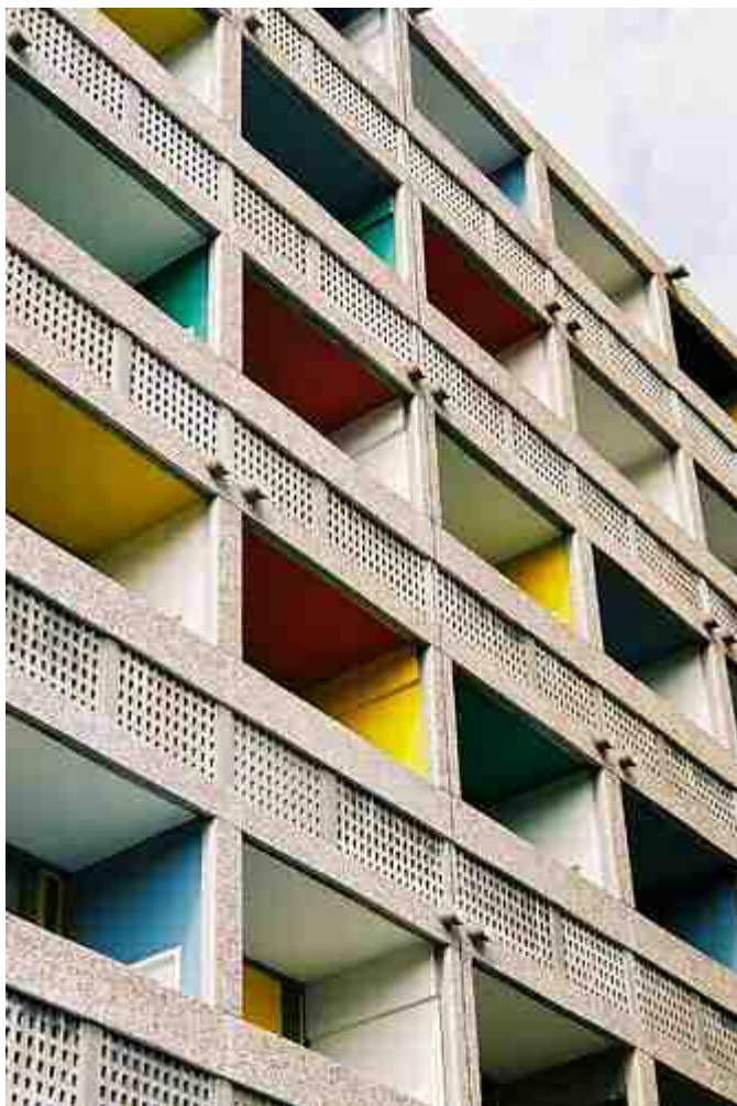
Imagem 65 - Casa do Brasil, Paris: fachada
