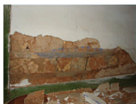
Pormenor da parede do quarto (6)
