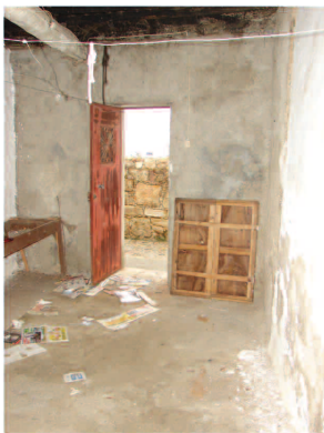
Vista do interior para a entrada(7)
