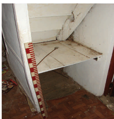
Prateleira sob a escadaria de acesso ao sótão (11)
