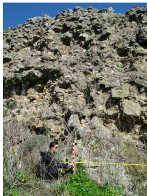
Imagem 13 - Medição da muralha com auxílio de um metro de madeira
