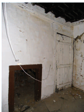
Porta de acesso à escadaria e vão por baixo da mesma (2)
