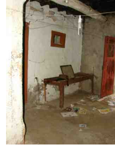
Imagem 39 - Piso térreo. Vista de dentro para a porta
