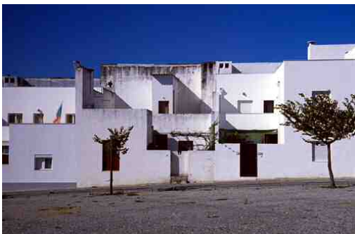
Imagem 71 - Moradias unifamiliares na Quinta da Malagueira
