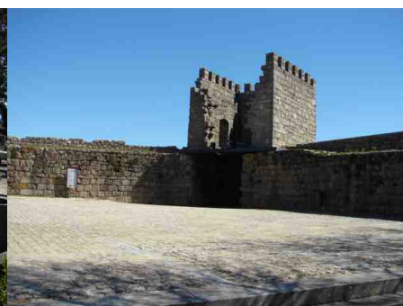
Imagem 5 - Zona do castelo após intervenção do programa POLIS
