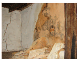
Pormenor do interior do armário (10)
