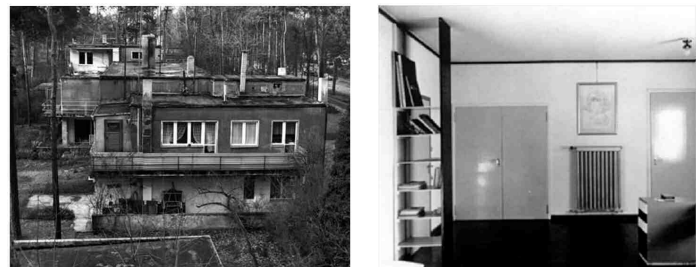
Casa de Georg Muche
