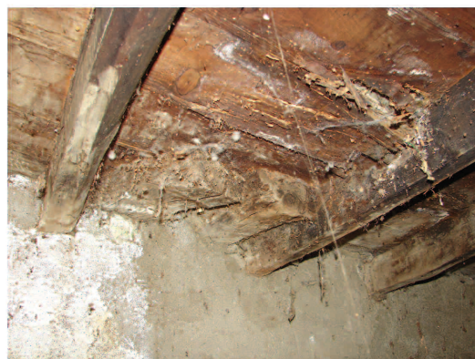
Pormenor do mau estado da construção
