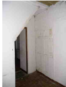
Imagem 41 - Piso superior. Porta de acesso à escadaria e vão que faz ligação ao anexo
