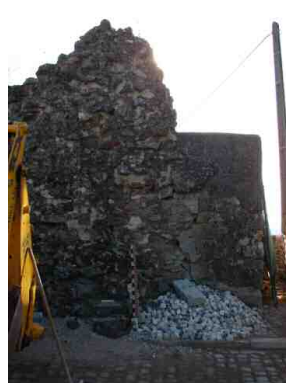
Imagem 14 - Medição da altura da muralha com auxílio de um metro de madeira
