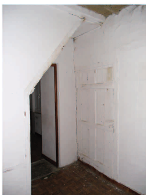
Vão aberto em parede estrutural para ligação à cozinha criada no anexo (14)
