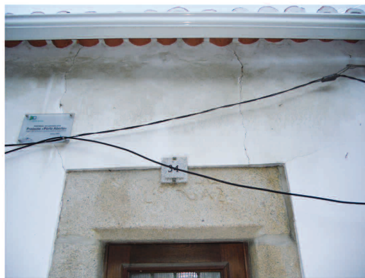
Porta n° 34 com inscrição "Lourenço Vaz" no lintel de pedra e identificação da intervenção do projeto "Porta Aberta"
