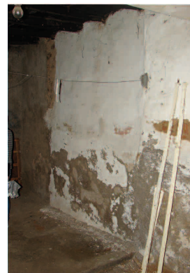
Parede da divisão e desnível do pavimento (9)
