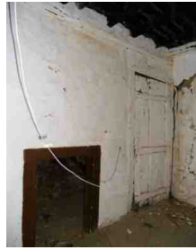
Imagem 37 - Piso térreo. Porta de acesso à escadaria que liga ao primeiro piso e vão de acesso à parte de baixo da escadaria
