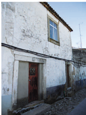
Fachada da Travessa da Rua Nova
