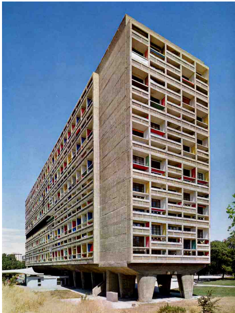
Imagem 57 - Exterior da Unit  d'Habitation
