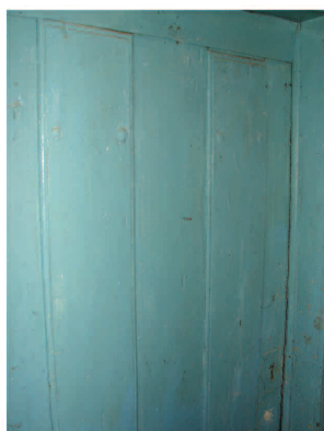
Porta interior que se propõe reabilitar/ recriar
