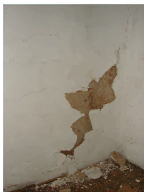
Parede do quarto (5)
