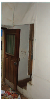
Patamar de acesso ao wc construído no anexo (15) e escadas para o sótão (16)
