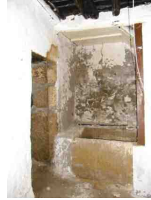
Imagem 38 - Tulha em pedra no piso térreo
