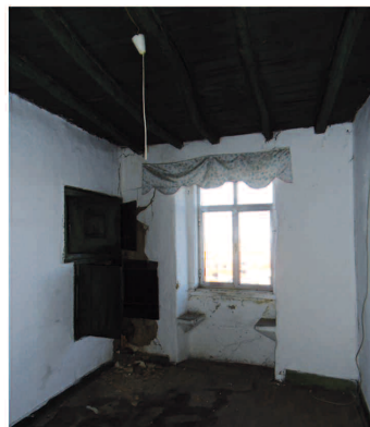
Quarto com janela para a Travessa da Rua Nova (6)
