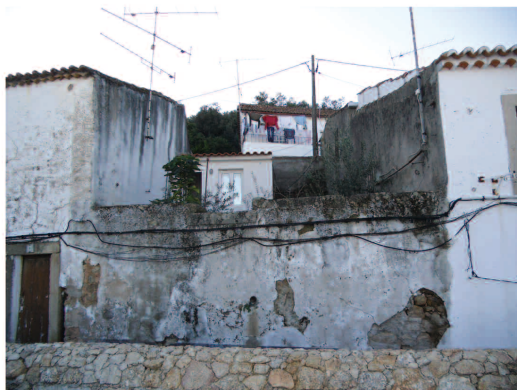
Fachada da Travessa da Rua Nova - vista do muro do logradouro e do anexo
