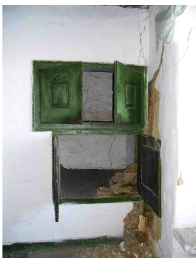
Imagem 77 - Armário pré-existente sobre a escadaria
