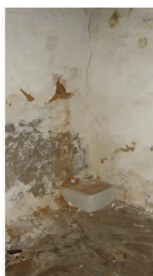
Única caixa de saneamento existente na construção original (10)
