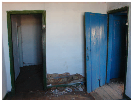
Interior de quarto (6) com porta para o patamar que permite aceder à escadaria e ao logradouro e porta para a divisão de entrada (1)
