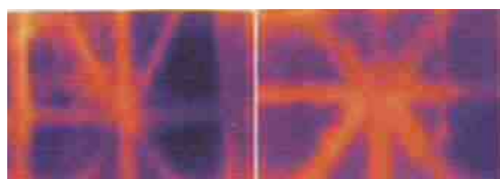
Figura 21 - Vista termográfica de parede pombalina relativa à imagem anterior onde se podem ver destacadas as treliças de madeira. (Cóias, 2006).
