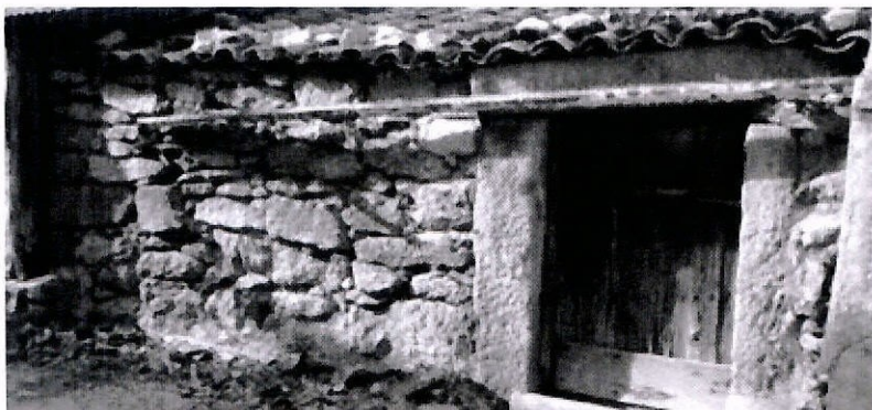
Figura 3 - Estrutura alvenaria de pedra no Norte de Portugal numa casa deixada ao abandono. Fonte da imagem: www.theroofabovemyhead.blogspot.pt/2009_08_01_archive.html
