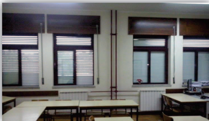
Figura 21 - Janelas da sala de aula.
