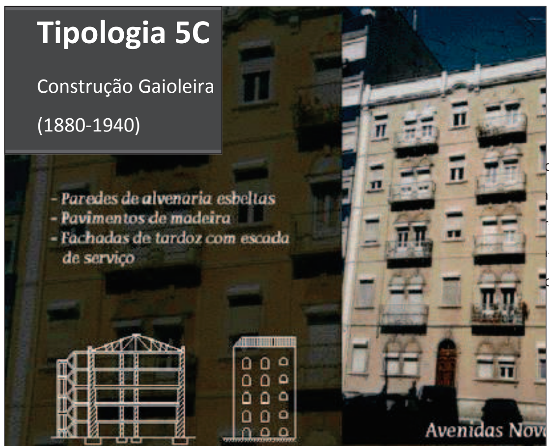
Figura 4 - Tipologia de um edifício em São Sebastião da Pedreira (SMPC Lisboa)
