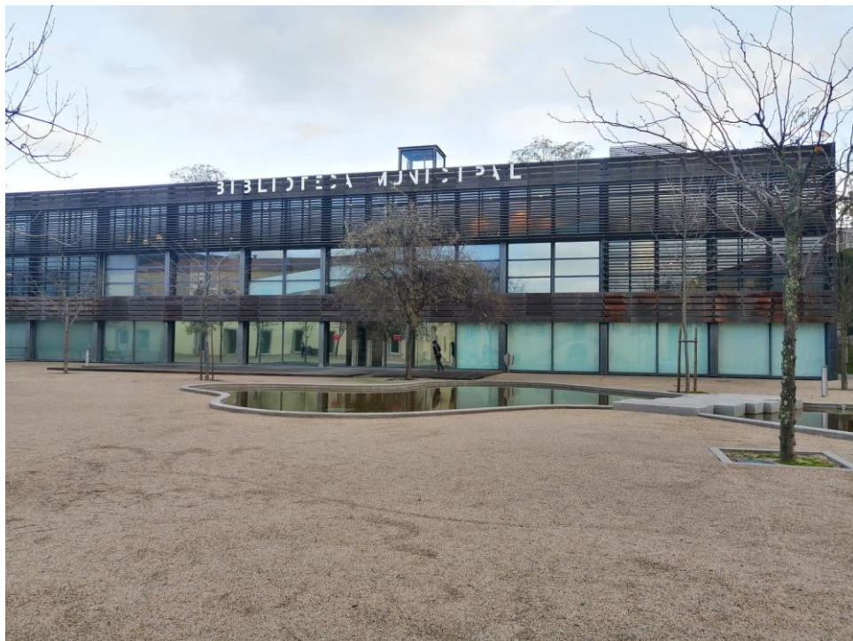
Figura 18- Biblioteca Municipal. Fonte: Carolina Tavares
