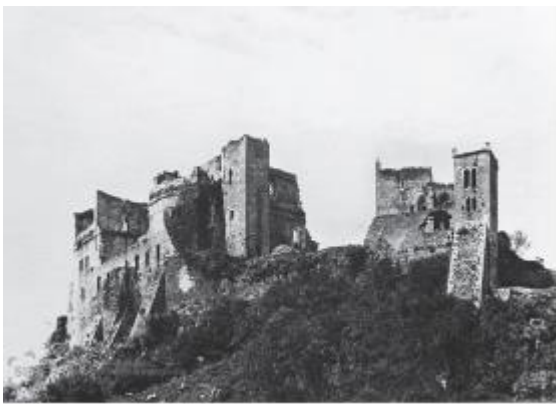
Figura 5 - Castelo durante as obras de reconstrução. Fonte - www.cm-leiria.pt .
