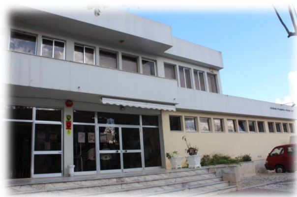
Figura 5 - Fachada da SFGP
