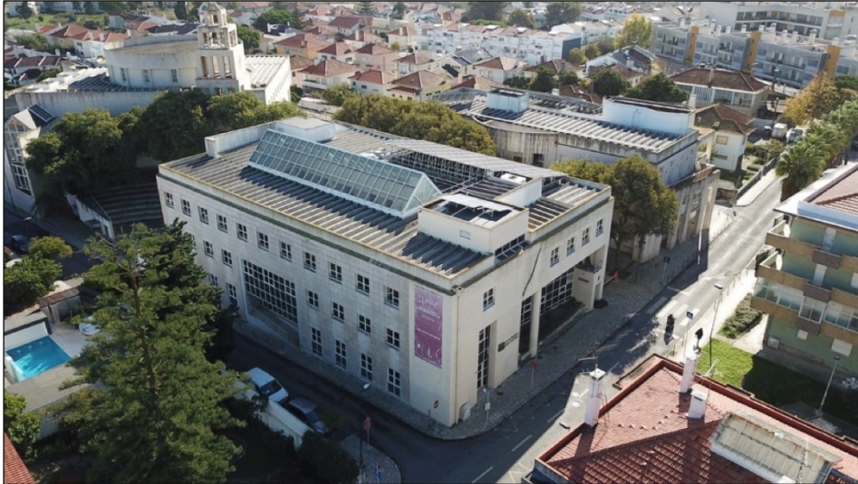
Figura 1- Vista geral da Escola de Música Nossa Senhora do Cabo
