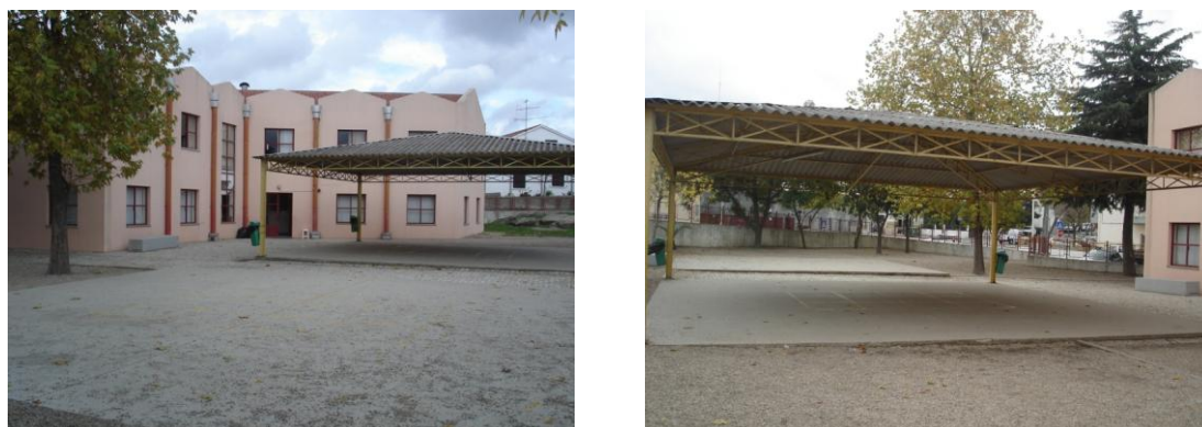
Figura 15 - Pátio exterior da escola
