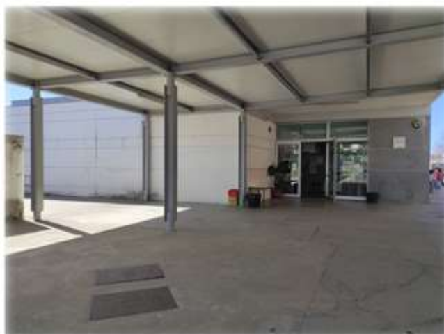
Figura 12 - Entrada do edifício destinado ao 1.º CEB
