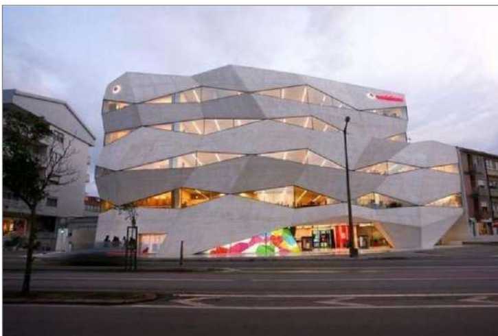
Figura 30 – Edifício Vodafone (Porto). Fonte: Vodafone, 2010
