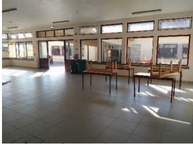
Figura 44 Átrio com porta de acesso ao pátio interior
