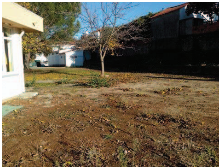
Figura 15- Parque exterior em remodelação
