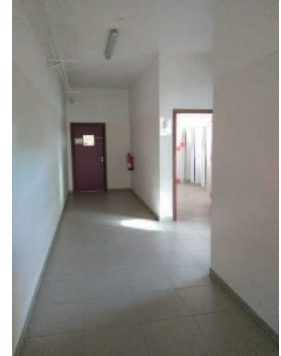
Figura 46- Casas de banho
