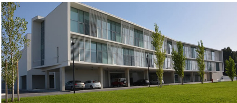
Fig.75 Instalações do CeI http://www.cataa-cei.pt/ImageGen.ashx?image=/media/126266/DSC_0733.jpg
