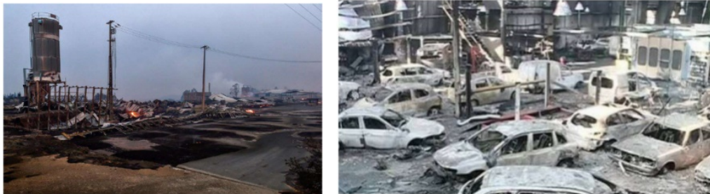
Figuras 1 e 2 – Edifícios industriais que foram afetados por incêndios florestais em 2018.
