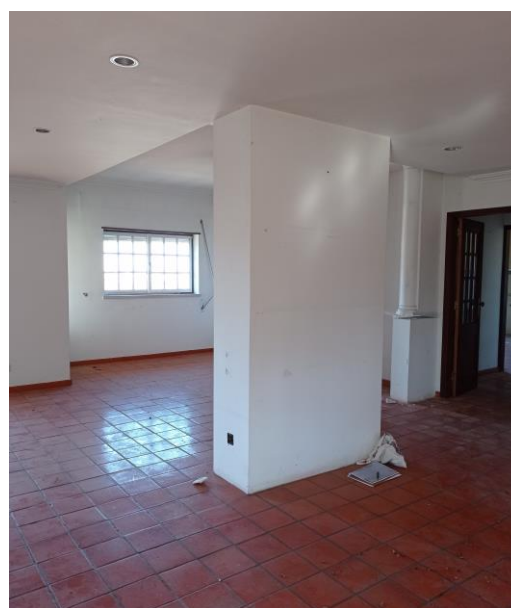
Figura 101 - Existente - Sala de estar. Fonte: Garq.
