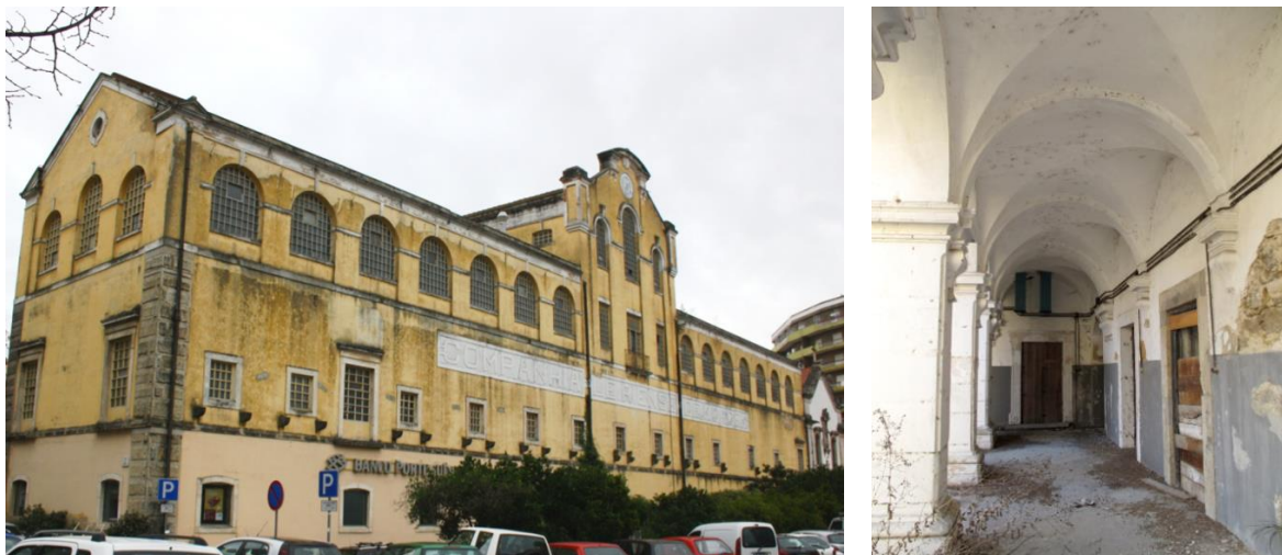
Figura 9 - Edifício da Moagem (Antes do projeto de reabilitação). Fonte: ( António Garcia Arquitectos , 2019).
