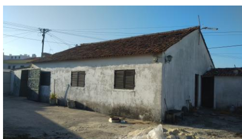
Figura 28 - Moradia existente a reabilitar (Moradia B). Fonte: Garq.
