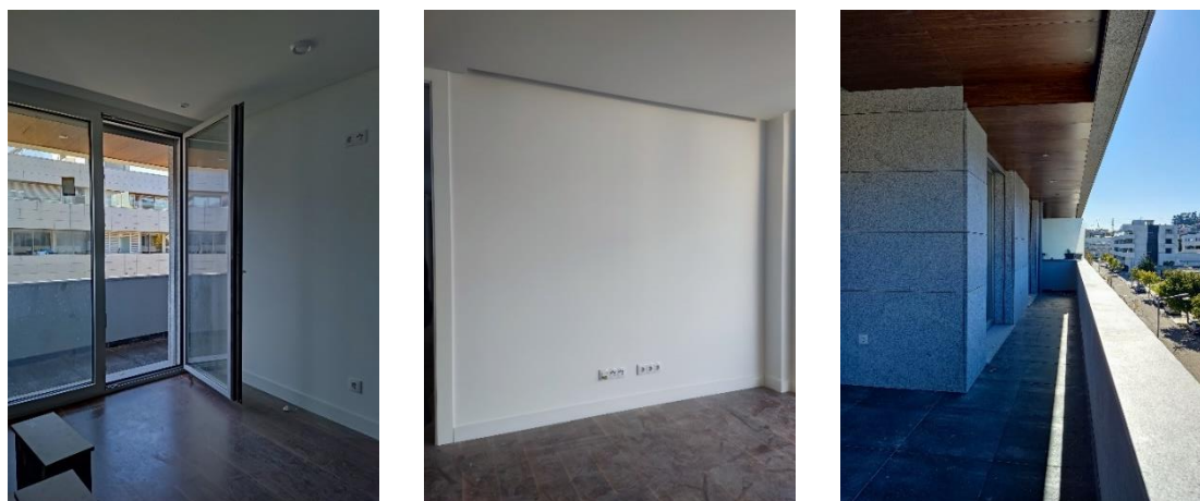
Figuras 100- Imagens do espaço em fase de acabamento de obra, P.33_FC; Fonte: Mariana Vieira.
