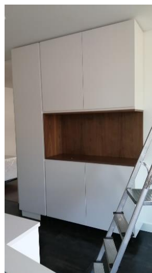
Figura 116- Fotografia do processo de montagem do móvel de auxílio de cozinha; Fonte: FBN_Arquitectura e Interiores.
