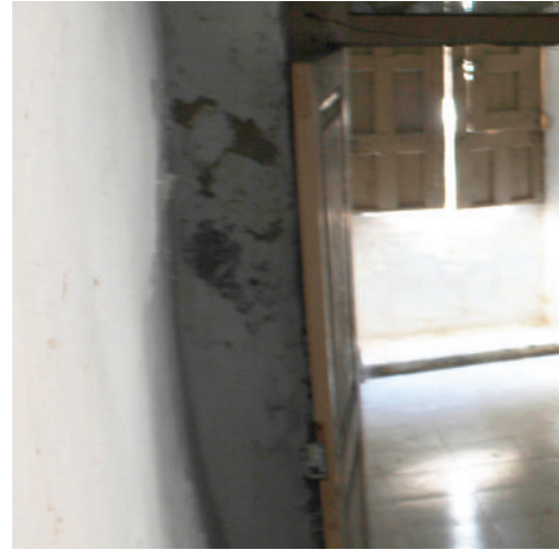
Figura 04.14 - Parede côncava, imagem da autora
