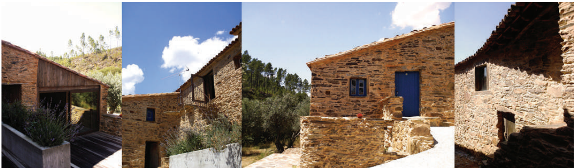
Figura 03.04 - "Xisto Sentido" visto pelo exterior, imagem da autora
