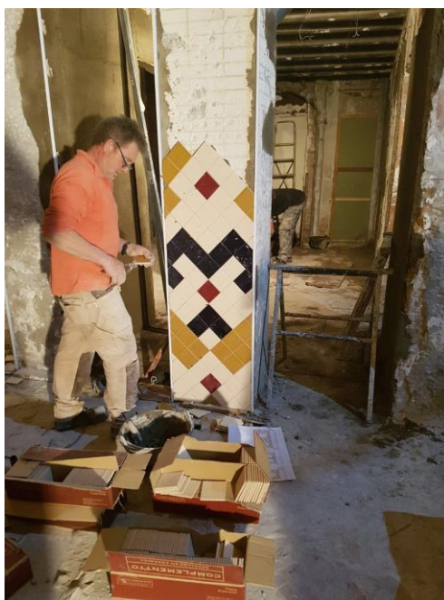
Figura 77 - Acompanhamento de obra, assentamento do revestimento cerâmico
