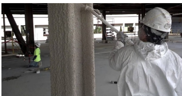
Figura 4: Exemplo de aplicação de argamassa projetada em torno de um pilar metálico.
