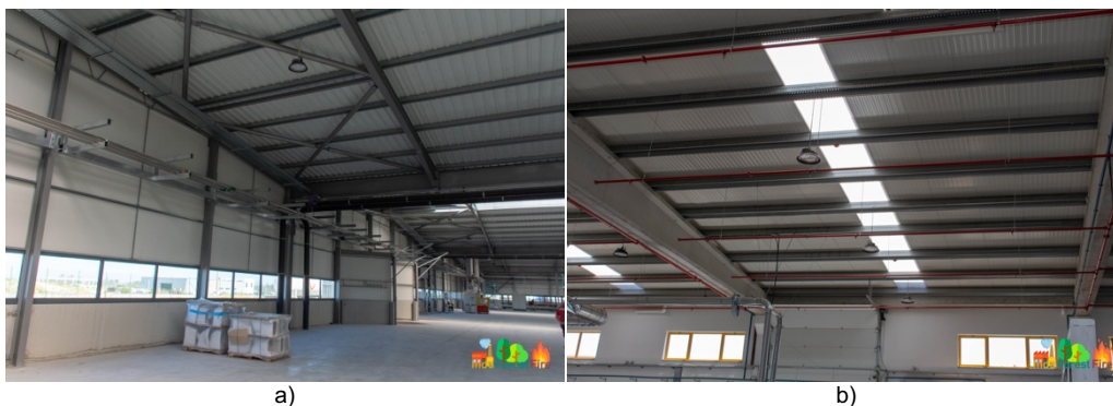
Figura 4: Edifícios reconstruídos – a) Estrutura metálica b) Estrutura em betão pré-fabricado
