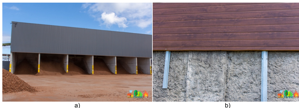
Figura 5: Fachadas após incêndio – a) Reparação pontual de fachada em chapa simples de aço; b) Instalação de painéis sandwich com PUR em fachada de alvenaria reparadas
