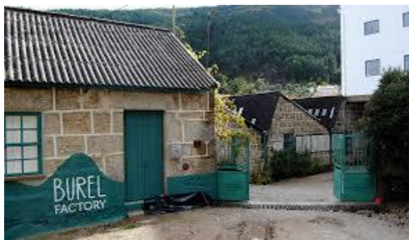
Figura 11 - Burel Factory - Exterior
