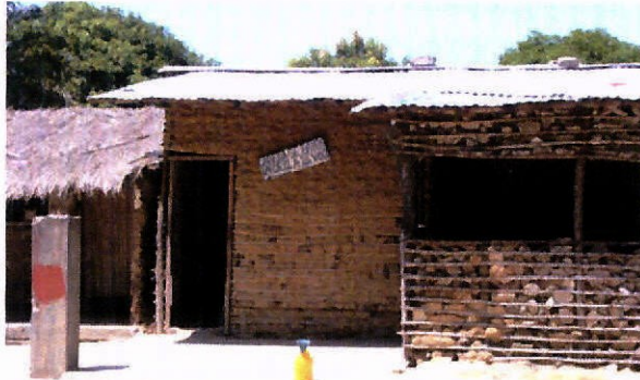
Fig. 2 - Construção de terra de recobrimento na vila do Nhangau, Moçambique.
