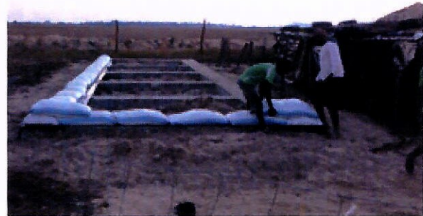
Fig. 6 - Colocação da primeira fiada de sacos.
