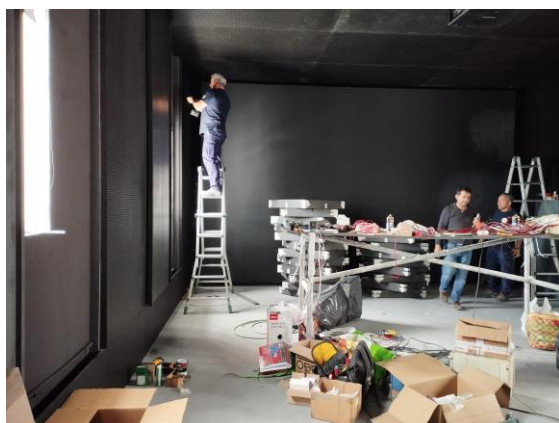
Figura 85 - Montagem - Sala de projeção (Fonte: Autora,2024)
