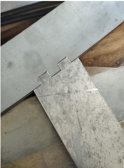
Figura 69 - Encaixes da estrutura metálica - Museu de Marinha Fonte: Ambienti D'interni (2023)
