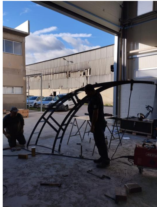
Figura 70 - Montagem da estrutura metálica - Museu de Marinha Fonte: Ambienti D'interni (2023)
