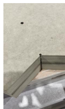
Figura 35 - Pormenor dos cantos executados pela cnc - Fundação Inatel (Fonte: Autora,2023)
