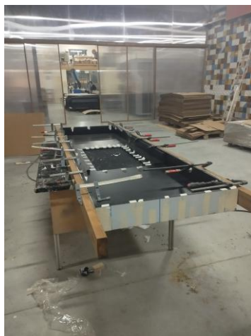
Figura 37 - Colagem do Inox - Fundação Inatel (Fonte: Autora,2023)
