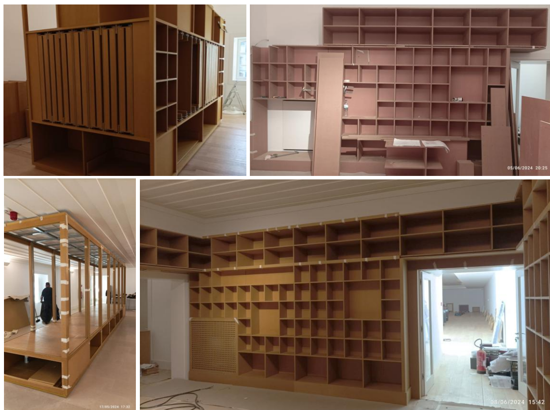
Figura 100 - Desenvolvimento do mobiliário em obra. (Fonte: Ambienti D'interni,2024).
