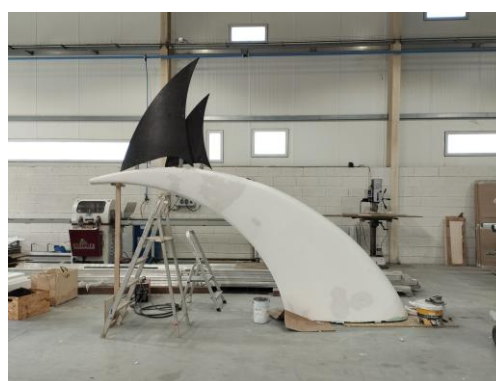
Figura 72 - Montagem das velas - Museu de Marinha Fonte: Ambienti D'interni (2024)
