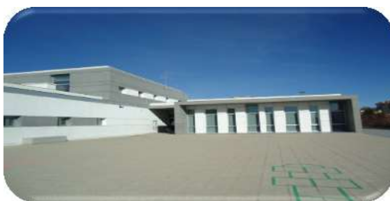
Figura 1- Bloco G, Escola Básica Integrada com Jardim de Infância Cidade Castelo Branco
