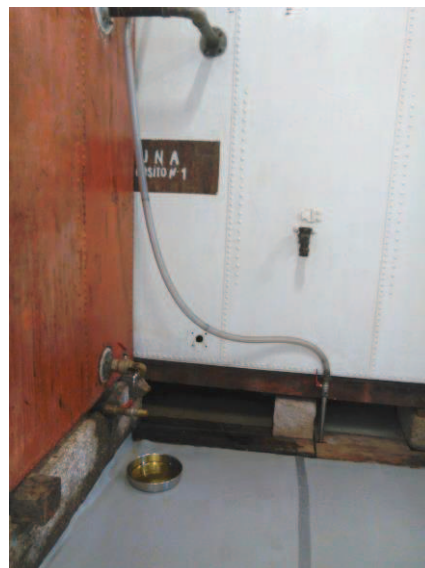
Figura 12 - Depósitos de azeite revestidos a resina epóxi.
