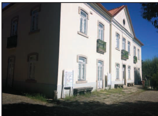
Figura 12 - Edifício a reabilitar (Alçado principal)
