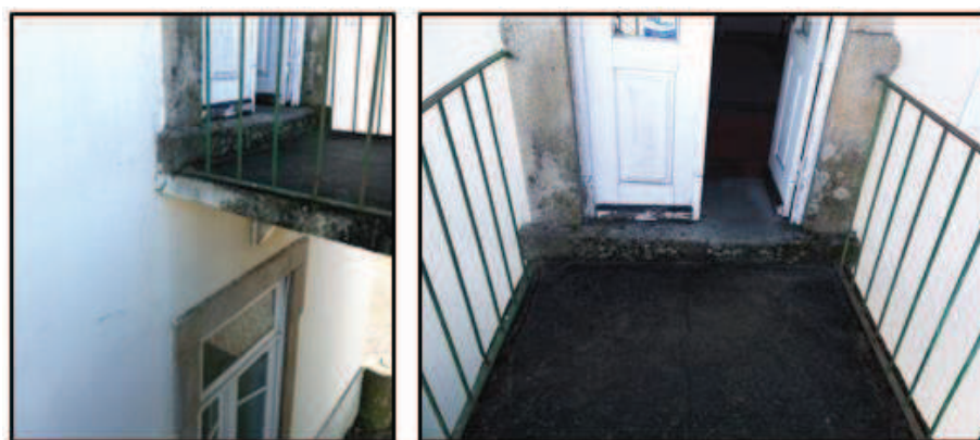
Figura 60 - Ligação da escadaria exterior ao edifício
