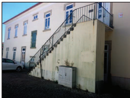
Figura 13 - Edifício a reabilitar (Alçado posterior)
