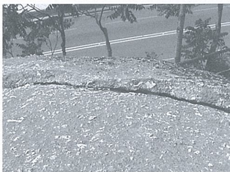
Figura 19 – Afloramento granítico evidenciado disjunção em “casca de cebola” – Estampa 33
