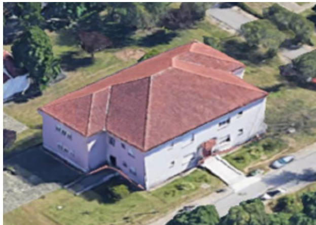
Figura 1 – Localização do edifício 2 no Polo HSC do CHUC, em Coimbra
