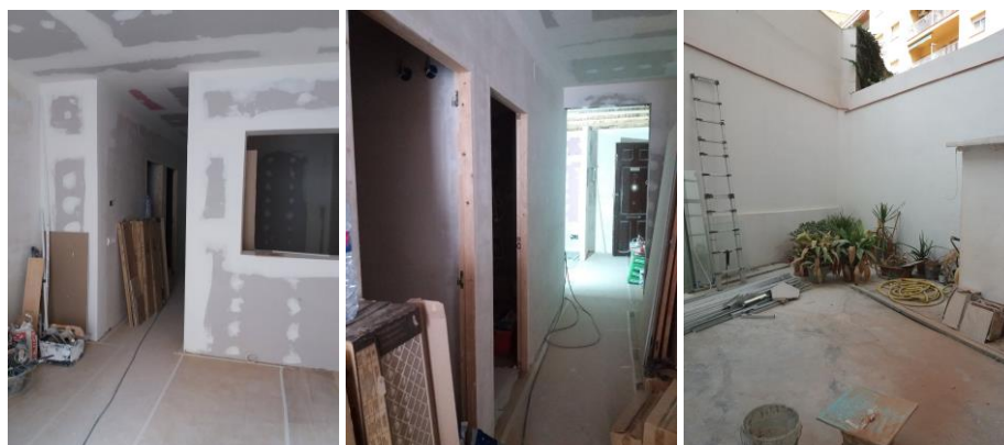
Figura 45 — Estado de obra, fotografias. Respetivamente, sala de estar com vista para sala de jantar, corredor, e por último o pátio exterior.
