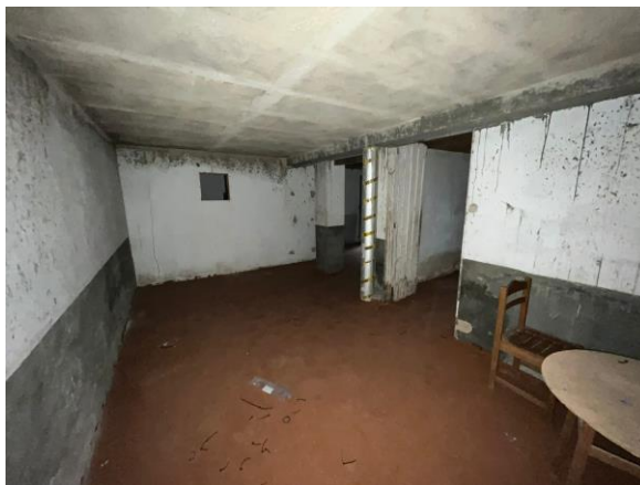
Figura 69- Cave, Prédio EG, Fonte: Ideias e Não Só Remodelação e Decoração de Interior.
