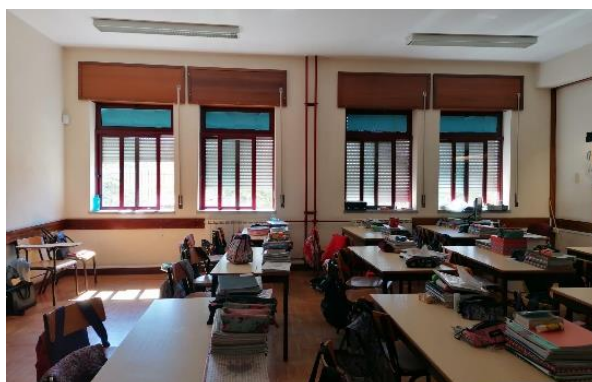
Figura 60 - Janelas da sala de aula
