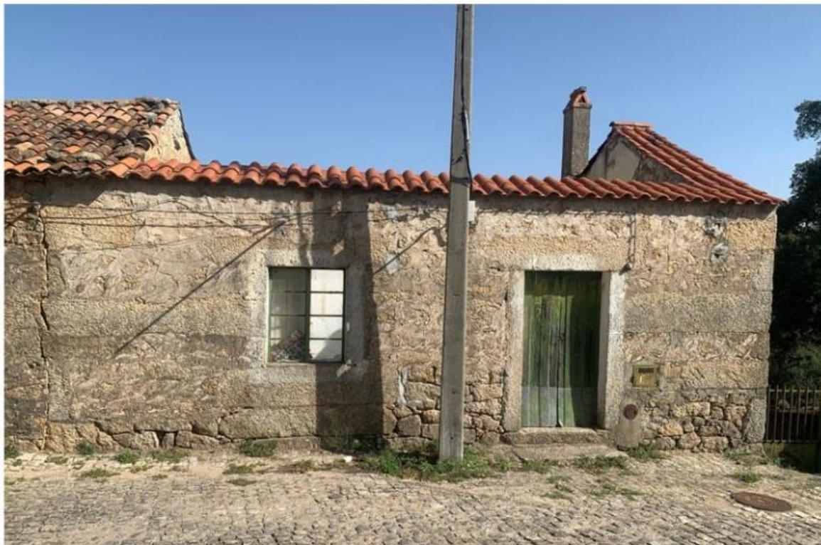
Figura 7 - Fotografia da 1ª moradia. Fonte: Arquiteto Nelson Valente
