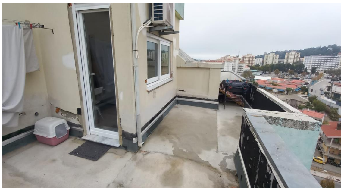
Figura 121 - Fotografia do edifício. Fonte: Arquiteto Nelson Valente
