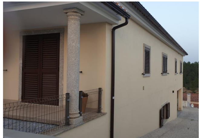
Figura 101 - Fotografia de Referência. Autor: Gabinete Arq. Nelson Valente
