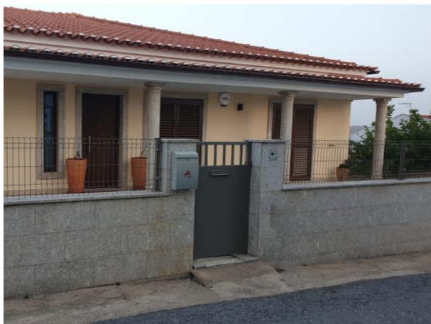
Figura 100 - Fotografia de Referência. Autor: Gabinete Arq. Nelson Valente
