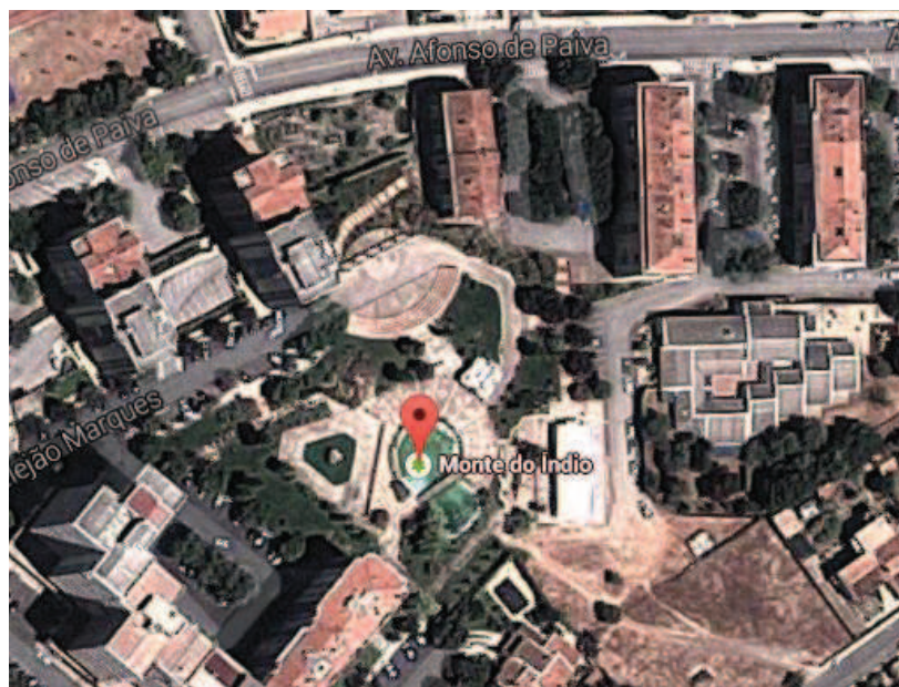
Figura 8- Vista aérea do Centro Infantil Afonso de Paiva- Santa Casa da Misericórdia.
