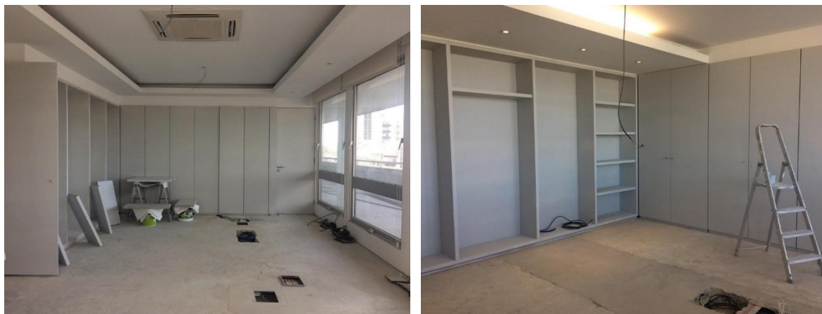
Figura 44 – Fotografias do acompanhamento de obra. Projecto 3. Fonte: Arkstudio.
