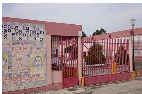
Figura 3: Escola Básica 2,3 Cónego Dr. Manuel Lopes Perdigão, Polo de Caxarias do Conservatório de Música e Artes do Centro.
