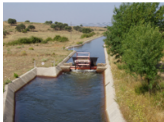
Figura 19 – Canal de rega controlado por comporta comandada por diferentes níveis do escoamento a montante e jusante.
