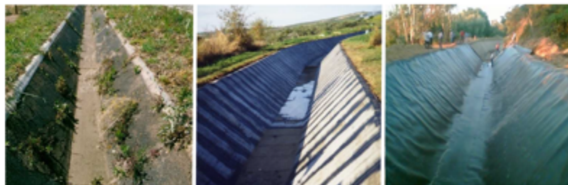
Figura 18 - Canal de betão antes e depois da aplicação de membrana betuminosa com aditivo anti-raízes, e troço de canal a ser revestido com membrana de polietileno (PE) (Morgado, 2008).
